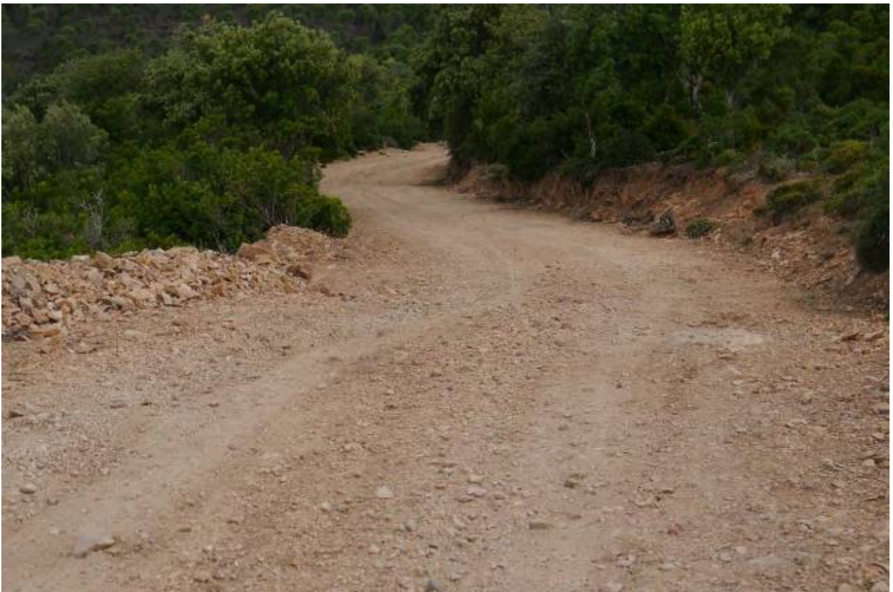
Foto 11. Tratto BC, in evidenza la presenza di un fondo non perfettamente regolare e l'assenza delle cunette laterali.
