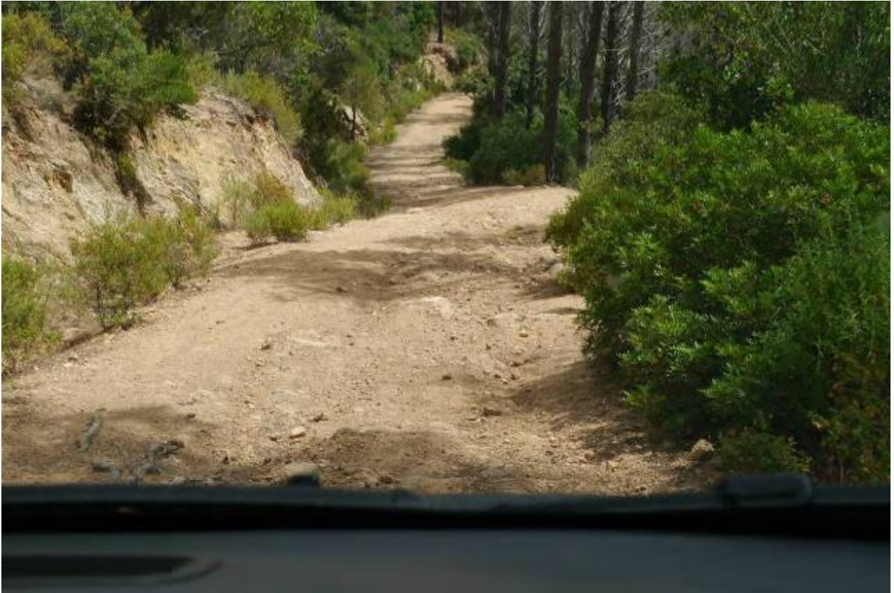
Foto 15. Tratto DE, particolare dell'elevato grado di dissesto causato dallo scorrere delle acque meteoriche.
